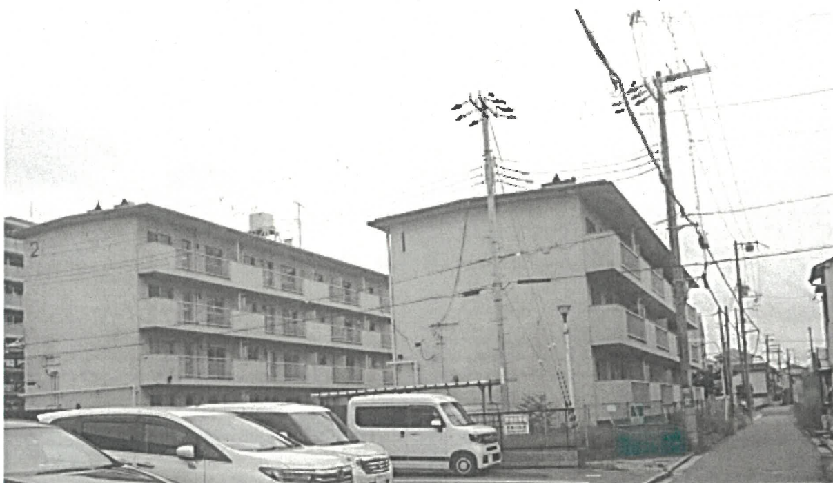
全景(左:2号棟、右:1号棟)
