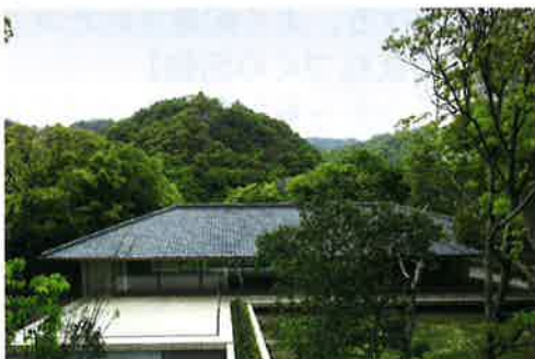
竹中大工道具館新館 (神戸市)
